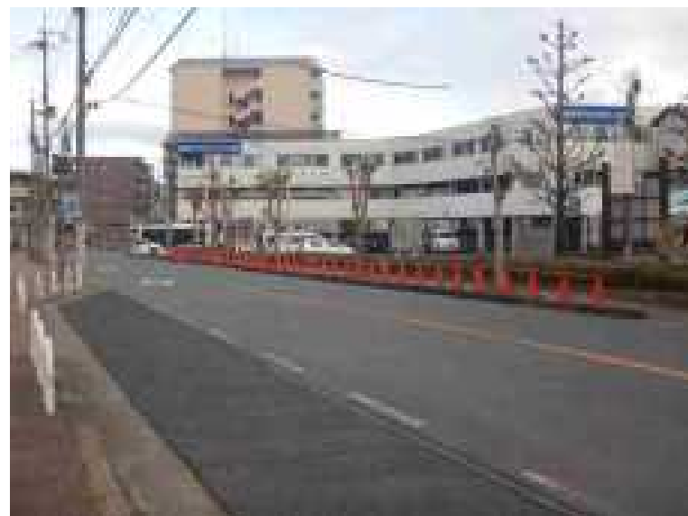
《簡易防護柵の設置》
